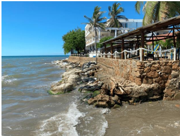
Figura 6-14. Estructuras de protección costera artesanal
