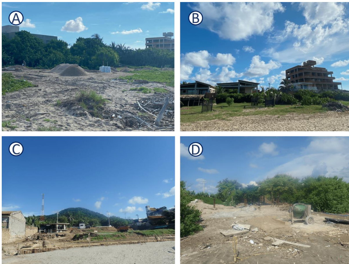
Figura 6-16. Construcciones aledañas a la playa. A, B y C) Construcciones ubicadas en el sector de Villas de Santa Verónica. D) Construcción en el sector de Salinas del Rey.
